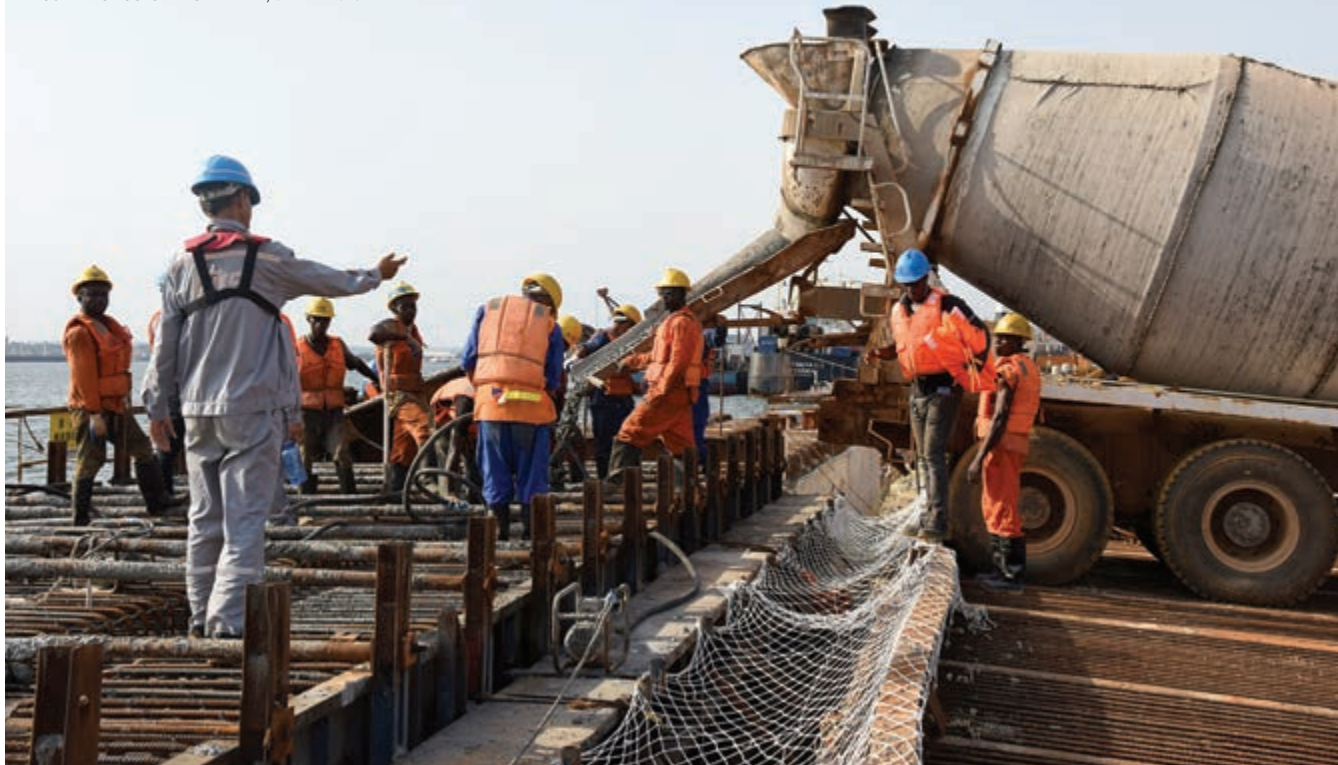
Des techniciens chinois et ivoiriens travaillent sur un terminal pour conteneurs au port d'Abidjan en mars 2019. La modernisation du port, prise en charge par des ingénieurs et des ouvriers chinois, a commencé en 2012. AFP/GETTY IMAGES
