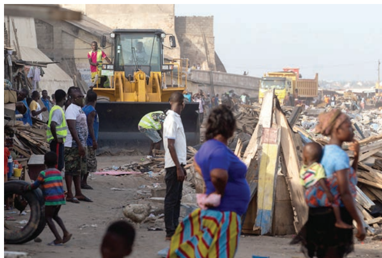
Residentes observam enquanto equipamento pesado limpa entulho durante a demolição na aldeia de pesca de Jamestown, em Acra, Gana. AFP/GETTY IMAGES
